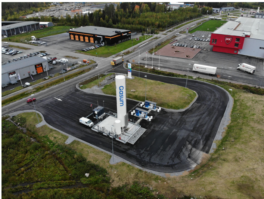
Exempel på biogasstation i Örebro. Gasum
